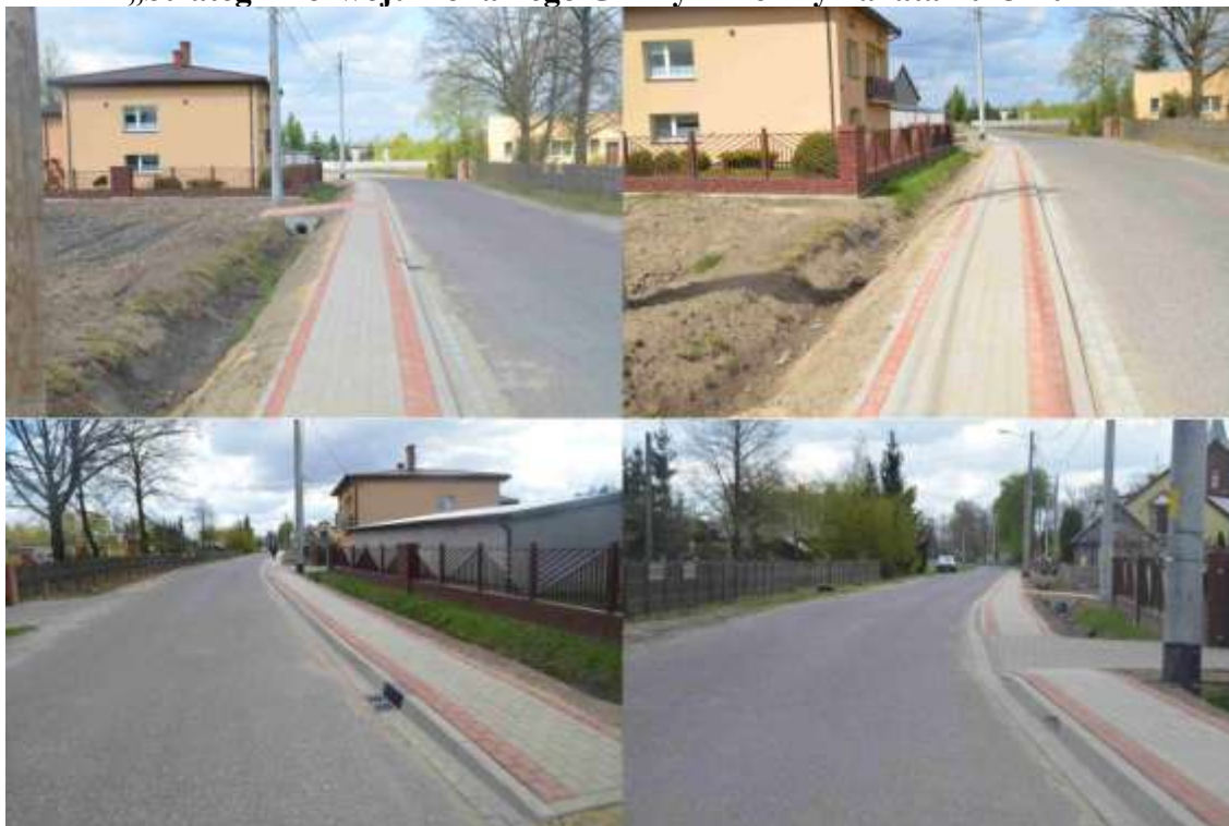
Przebudowa drogi gminnej nr 676138 P w miejscowości Sobieszki obejmującą przebudowę chodnika
