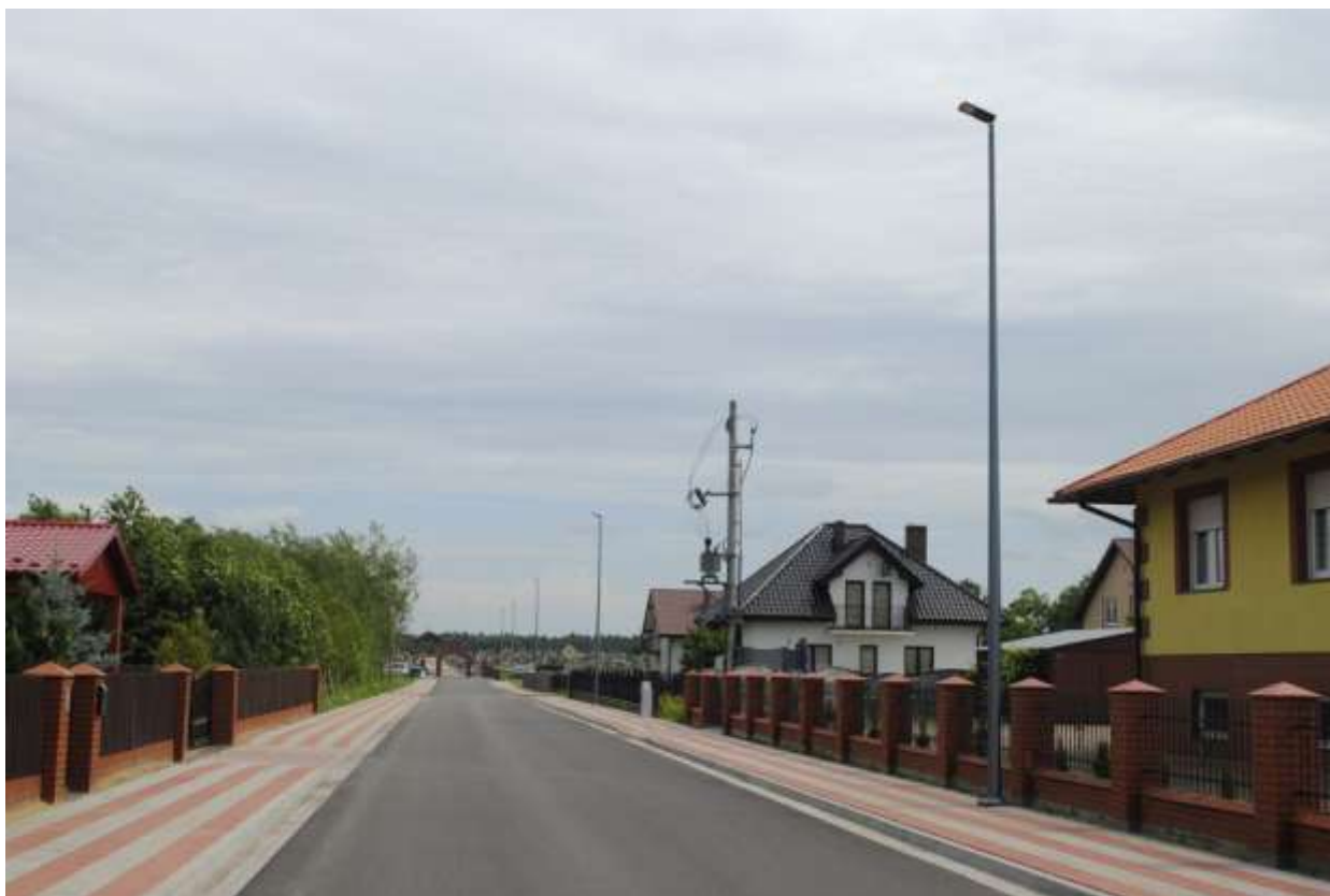
Przebudowa drogi gminnej w miejscowości Brzeziny – ulica Klonowa oraz część ulicy Jodłowej i Dębowej
