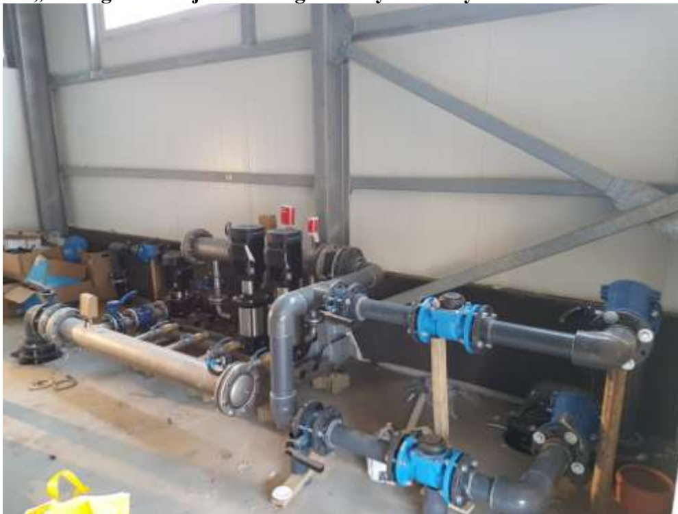
„Poprawa stanu gospodarki wodnej poprzez budowę stacji uzdatniania wody w miejscowości Piegonisko Wieś oraz wyposażenie stacji uzdatniania wody w miejscowości Pieczyska – ETAP I”
