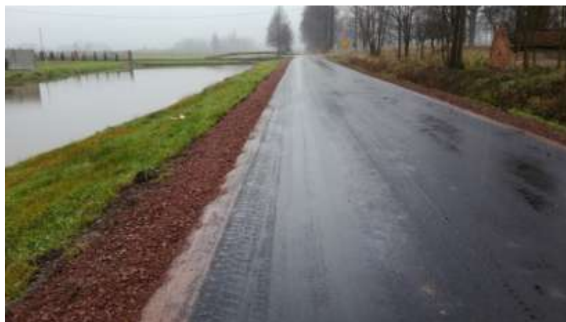
Przebudowy nawierzchni drogi gminnej w miejscowości Ostrów Kaliski na działce Nr 539 oraz drogi gminnej w miejscowości Pieczyńska na działce Nr 365”
